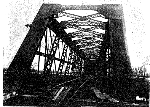
(3) 揖斐川橋梁・左岸より桑名方を望む。
