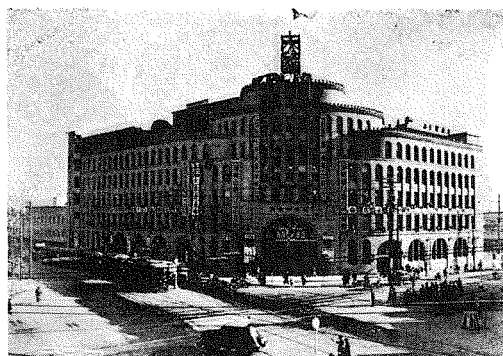
(1) 起點大軌停車場全景。
