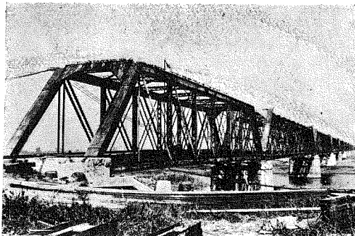
(4) 木曾川橋梁橋・右岸より古屋方を望む。
