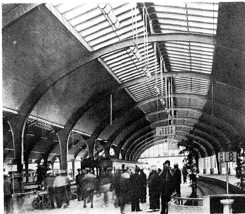
(1) 竣工せる南海鐵道難波驛高架ホーム全景。
