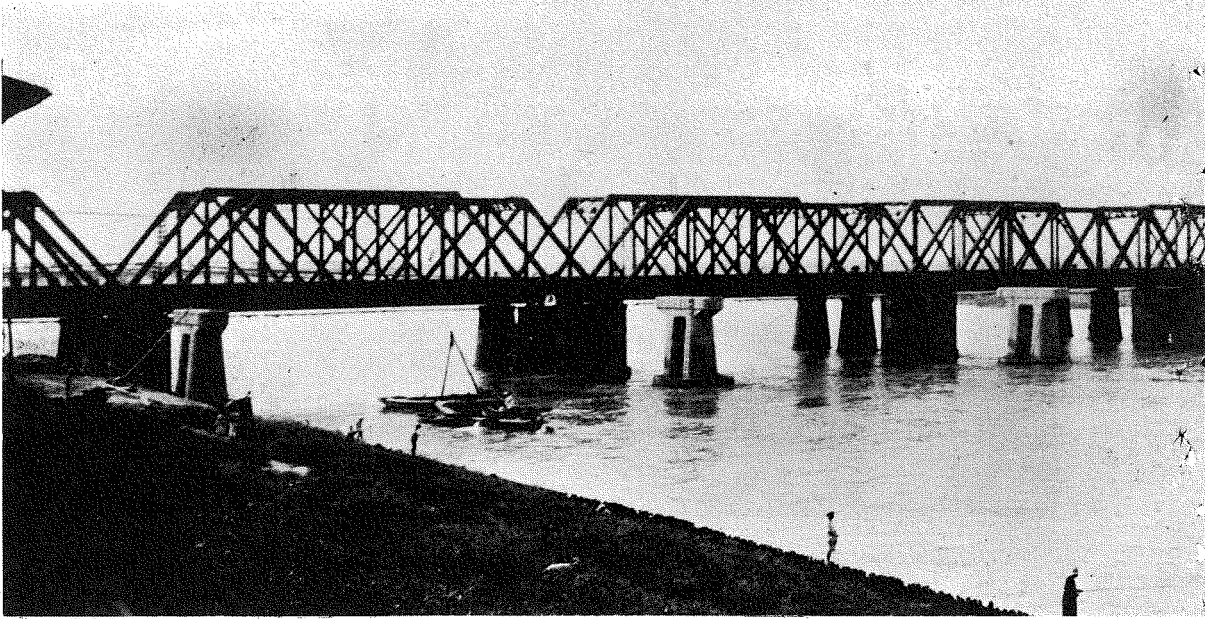
(1) 上淀川橋梁増設工事全景(4-9)
