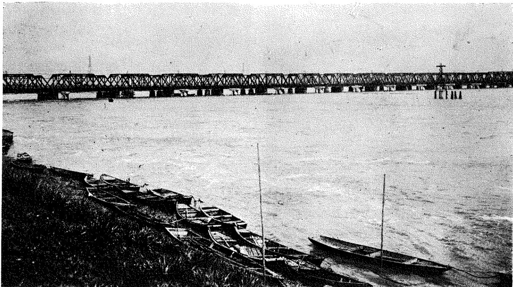
(11) 洪水時に於ける工事全景(8-3)
