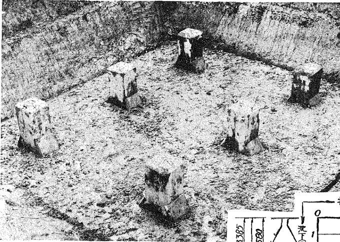
第10圖 打込みを終つた橋脚基礎杭の一組。
