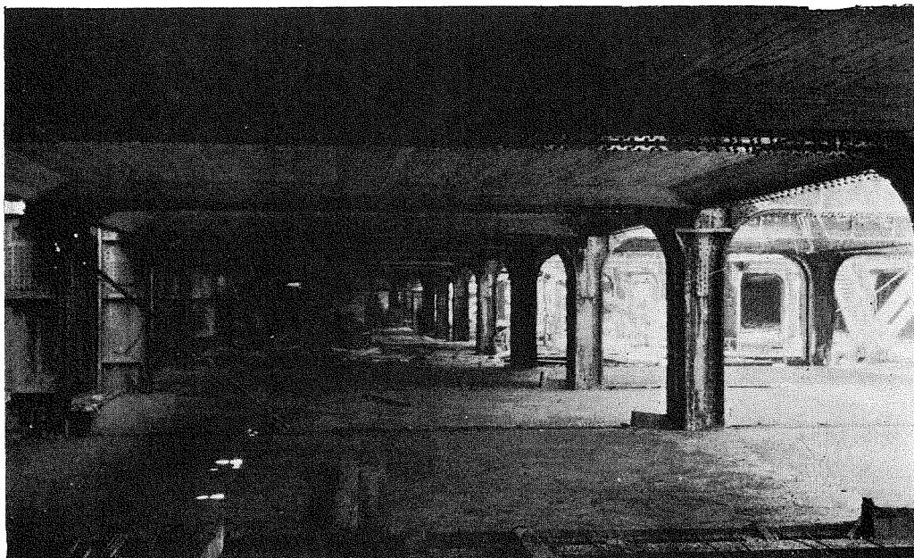
(6)中部床版完了し 第2段切梁に代用す る。
