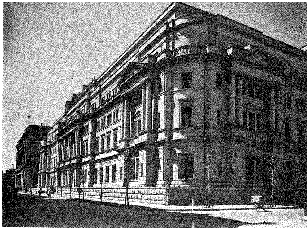
(4)新館東面・第2期工事により竣 功せるもの前方に 長野博士設計によ る横濱正金銀行の 建物を見る。
