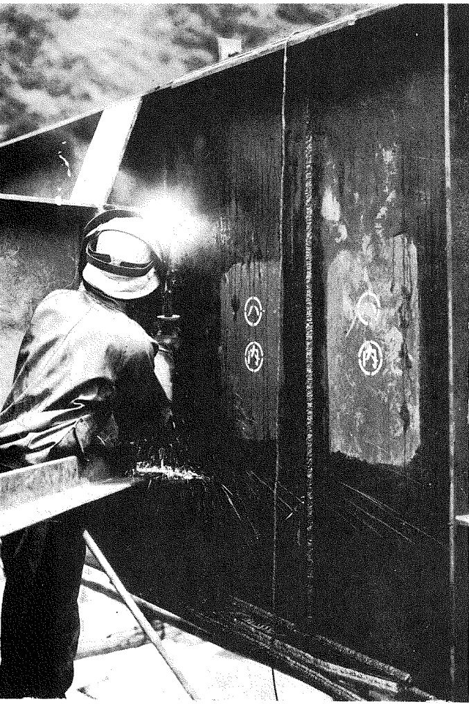
(21)主桁現場溶接を完了した後横桁の取付溶接作業中の状況。
