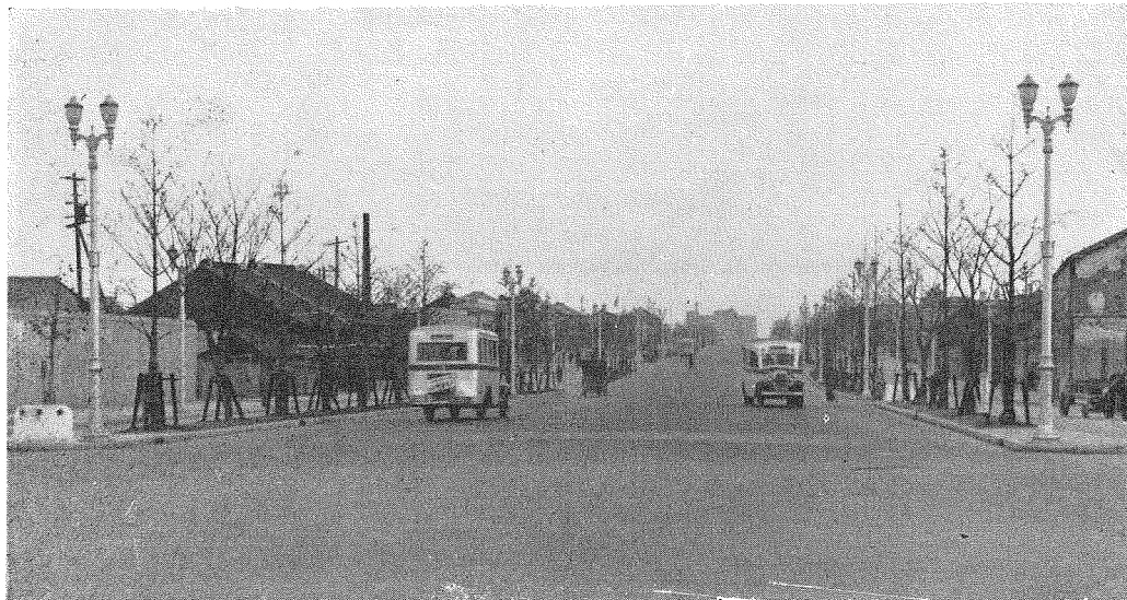
(1)竣工せる道路の全景。
