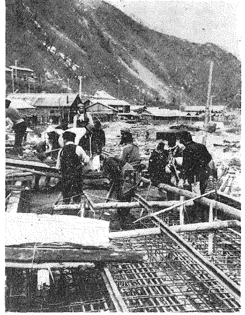
(6) 桁上部床版 コンクリート施 行状況。
