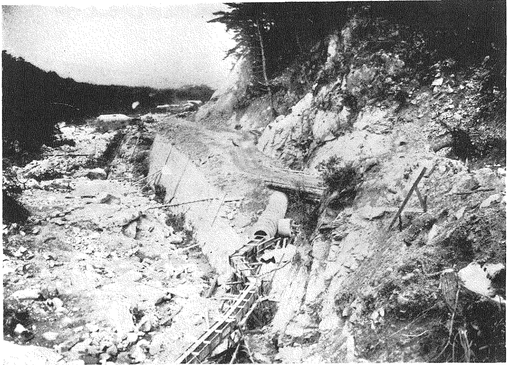
(6) 起點より 3,400 米附近、 西宮水道取水路 と交叉箇所施工 中の状況。
