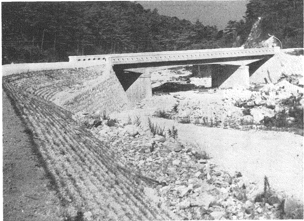
(5) 起點より2,900米 の地點、仁川に架設せる 鷲林寺橋(鐵筋コンクリ ート突桁橋、橋長28.0米、 員7.0米)
