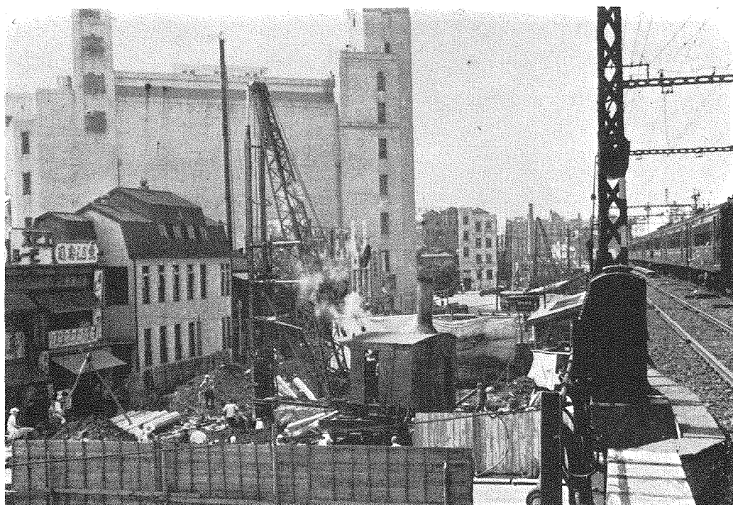
(3) 有樂町驛附近に於ける基礎杭打状況。
