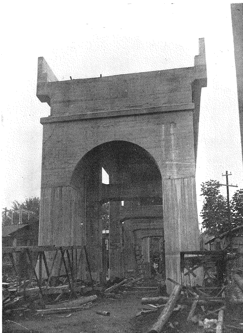
(1) 出来上つた宮益坂の高架橋。
