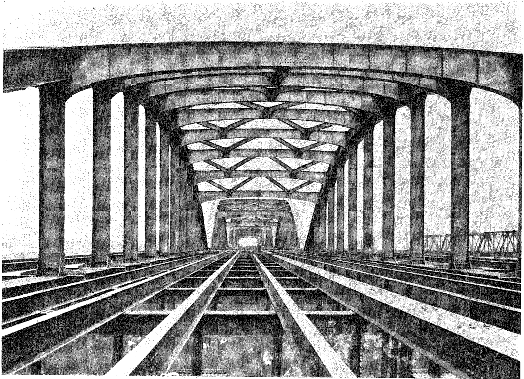
(7) 竣工せる新淀川橋梁ランガー桁の正面。
