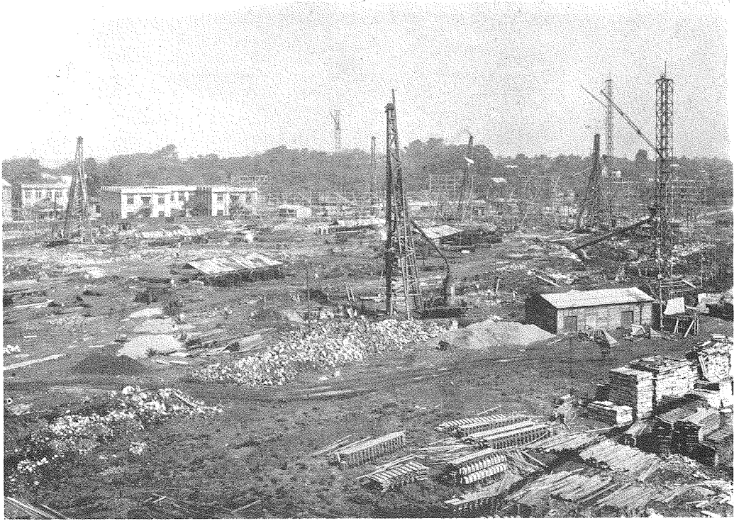
(4) 基礎杭打中のスタジアム。
