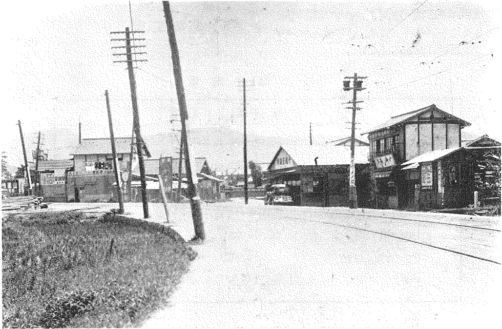
(18) 工事施行前の終點附近道路、松山市内。
