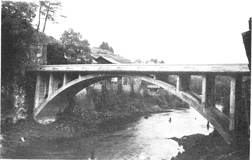
(5) 完成せる馬見原橋
