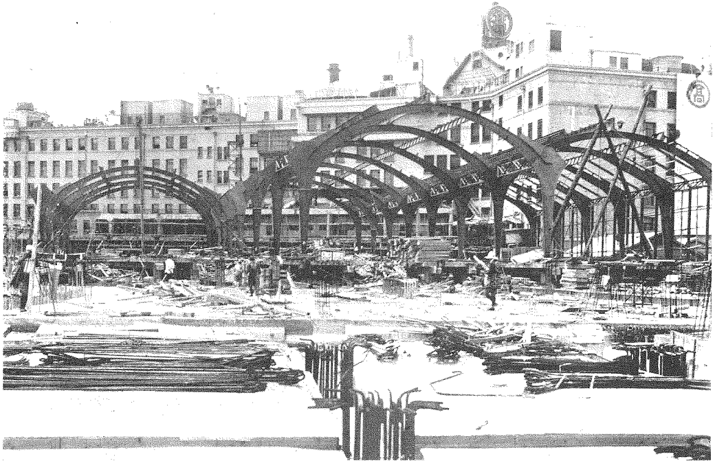
(4) 巖波停車場上家鐵骨組立。
