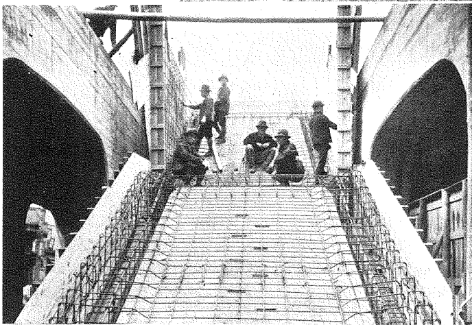
(12) 萩の茶屋停車場昇降 階段工事状況。
