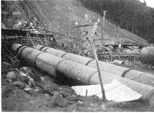
(4) 工事中原町発電所水圧管。
