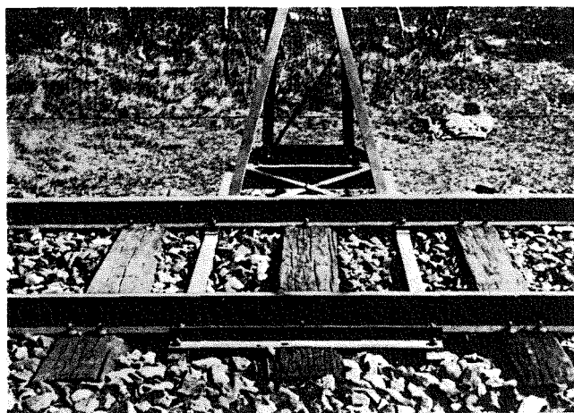
(3) 列車停止装置と連絡してゐる踏子。
