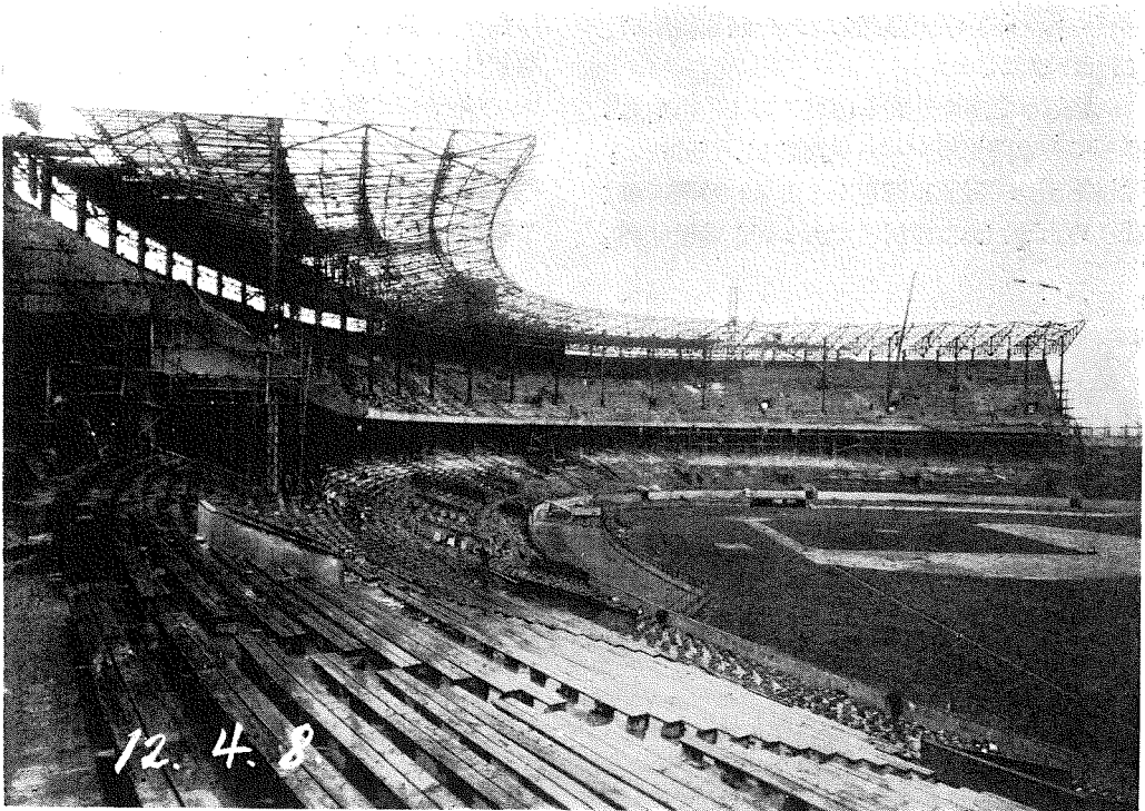
(6) 竣工近き球場の内 部、観衆工事の状況。
