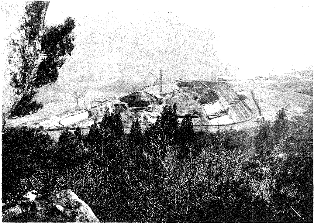
(4) 工事中の原町発電所調整池全景。
