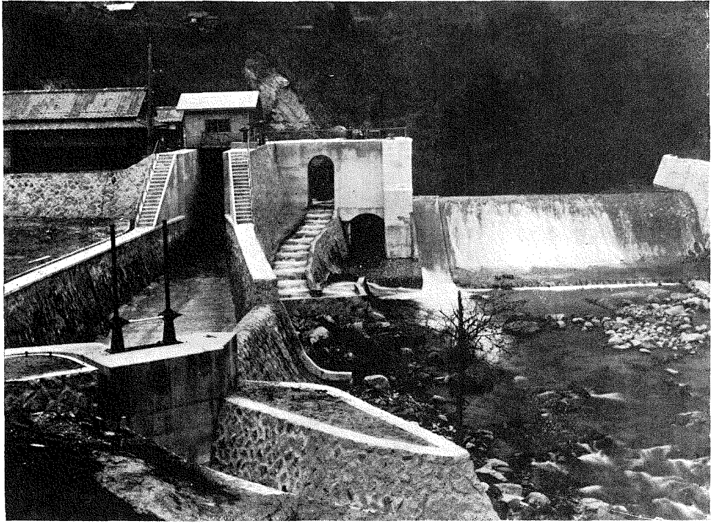
(14) 湛水後の和合堰堤を下流より見る。
