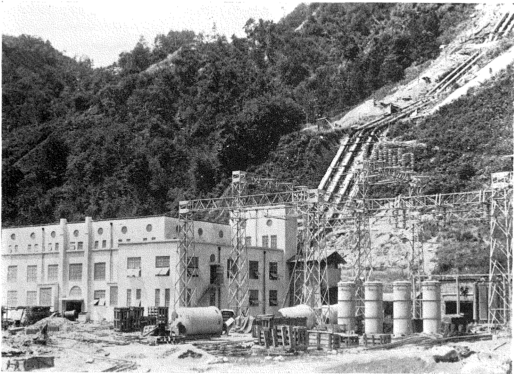
(17) 發電所と 水送鐵管 路の一部。
