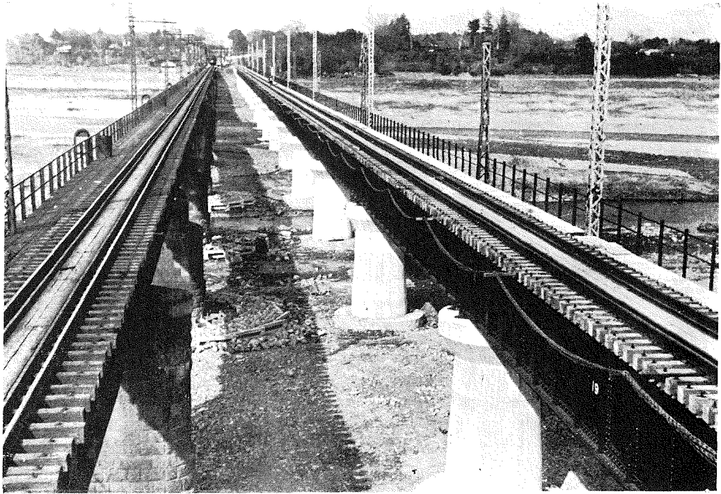
(21) 鐵桁架設を終了し完成せる橋梁。
