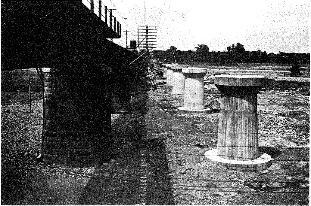
(11) 下部構造成れる多摩川橋梁（左方は現在橋梁）
