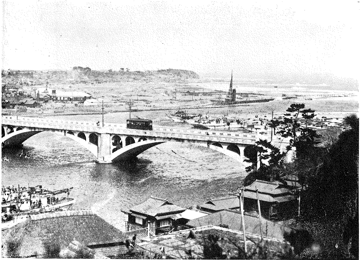
たる那珂湊港全景。(橋梁は海門橋)
