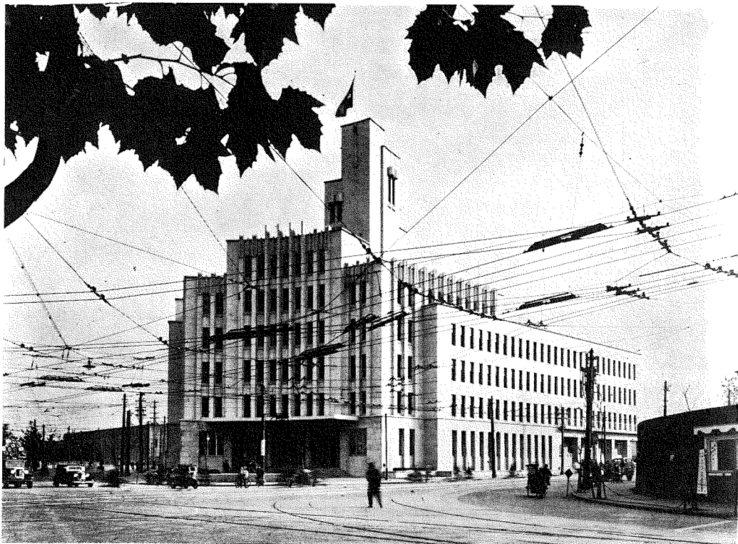
(1) 大阪中央放送局正面全景。
