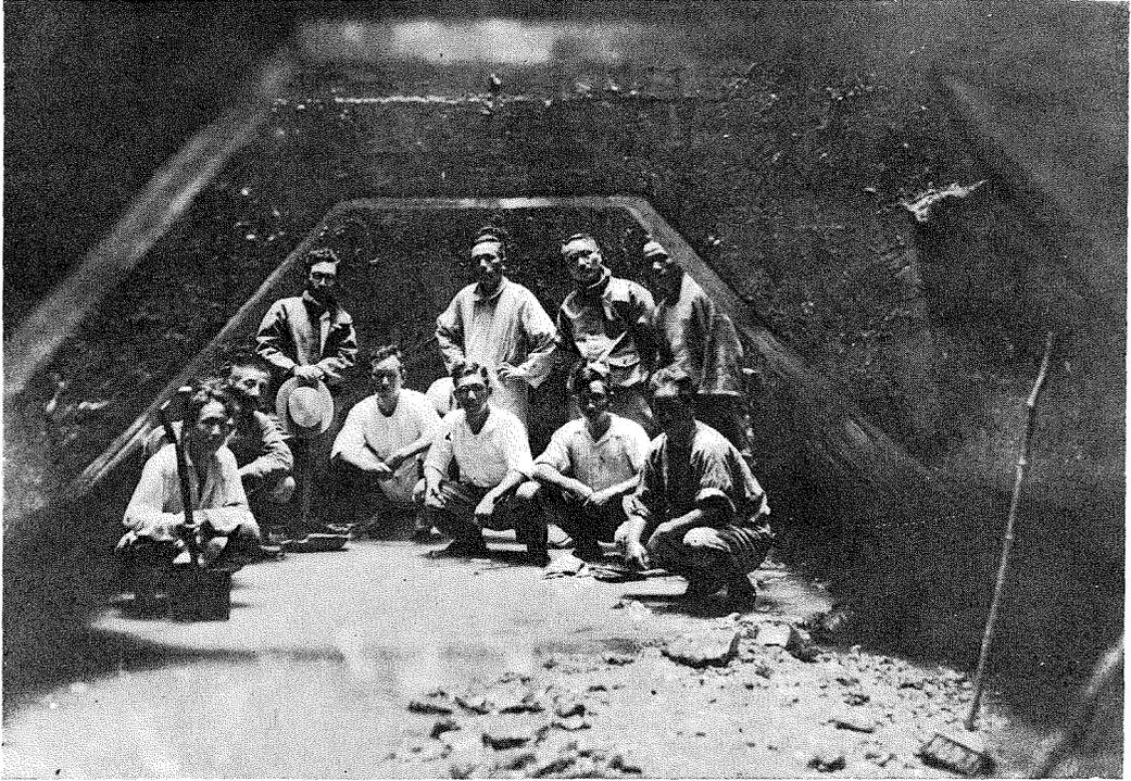
(8) 底部コンクリート施工前の井筒底部、昭和 11 年 9 月 11 日午後 5 時の撮影にして後列左端（立つる）が殉職せる深田工學士、二人目は河戸橋梁擔任技師。
