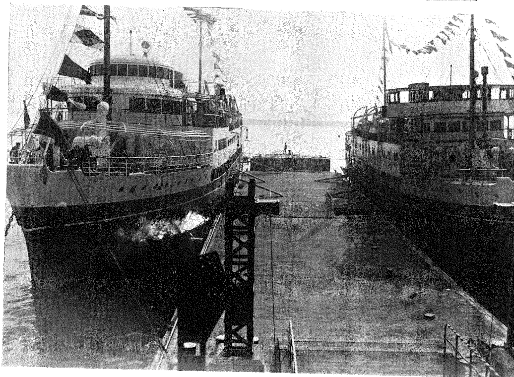
(11) 渡橋用鐵塔より浮函及ドルフィン展望。浮函上木箱の點在するは上層の柱位置。
