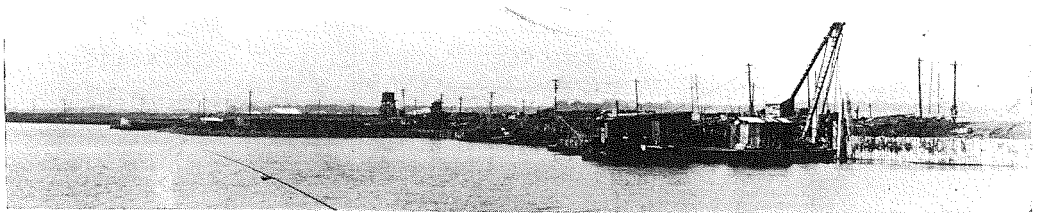
(2) 工事手當時の現場。
