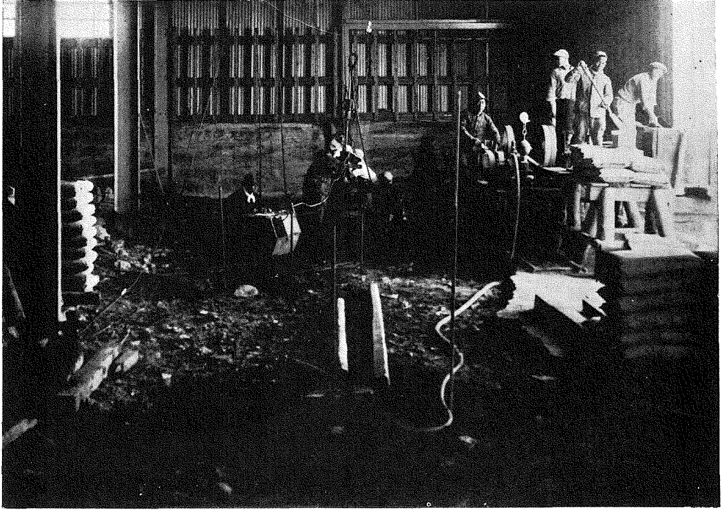
(12) セメント乳注入作業
