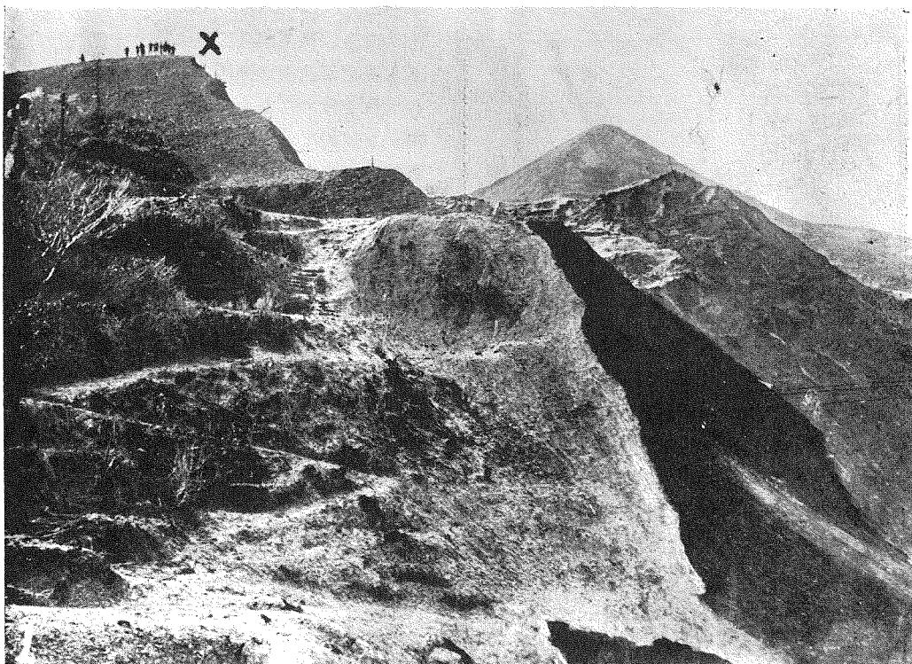
(1) 尾去澤鑛山ダム決潰現場(X印)向つて右方は鑛泥奔流の跡。
