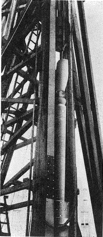
写真4・内管を吊り上げ、内管よりコンクリートを投入する。
