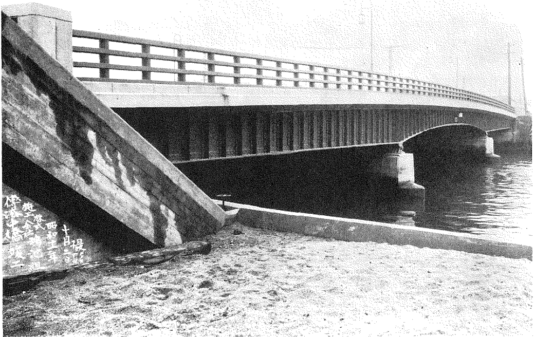
(5) 竣工せる傳法中橋側面。
