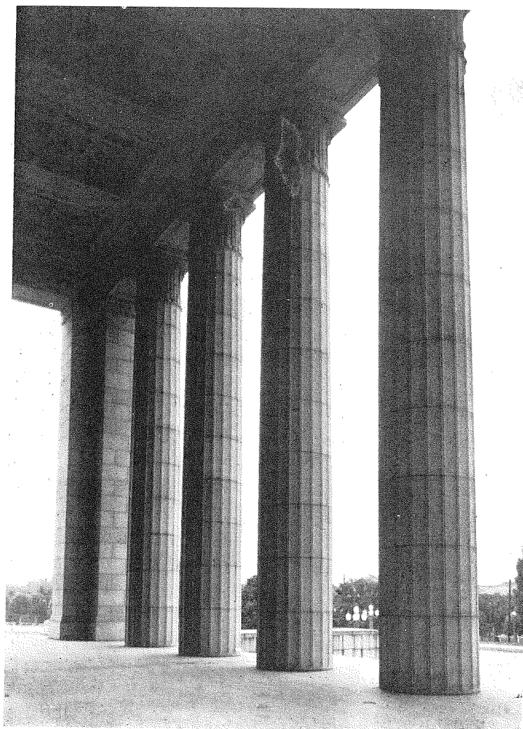
(16) 中央玄関の大圓柱・長48尺、太さ6尺
