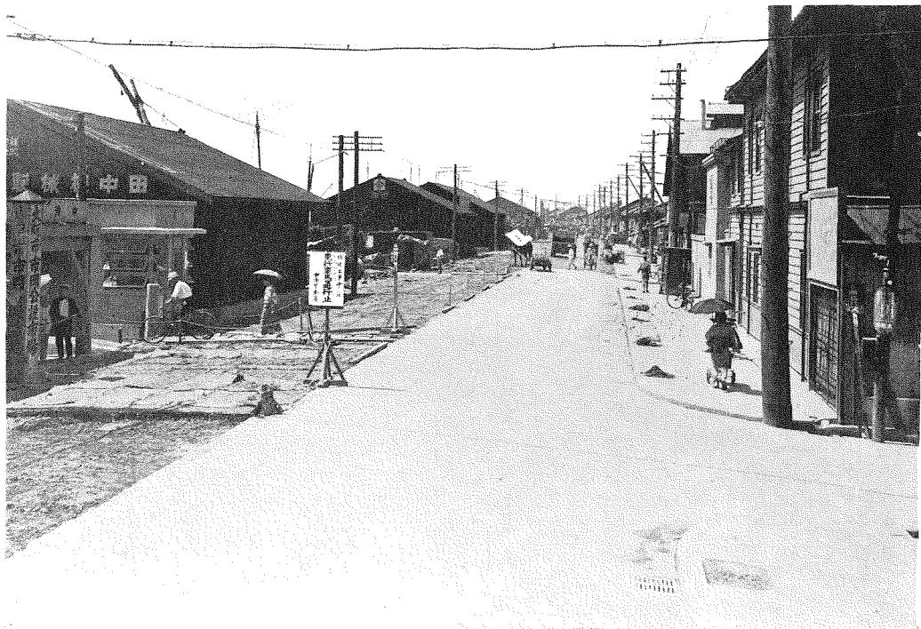
(3) 車道基礎コンクリートを打終り養生中の状況、右方は完成した部分。
