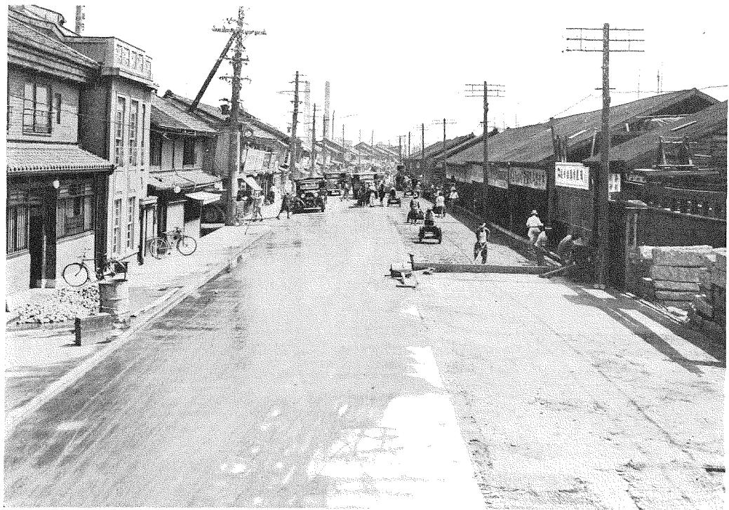
(2) 車道基礎コンクリート敷均作業・コンクリート・ミキサーはコンクリート作業1日分後退し、コンクリートは運搬車にて運搬する。
