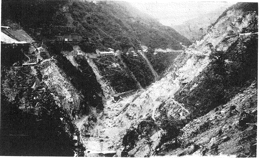
(1) 九州送電塚原堰堤工事を上流より見る。
