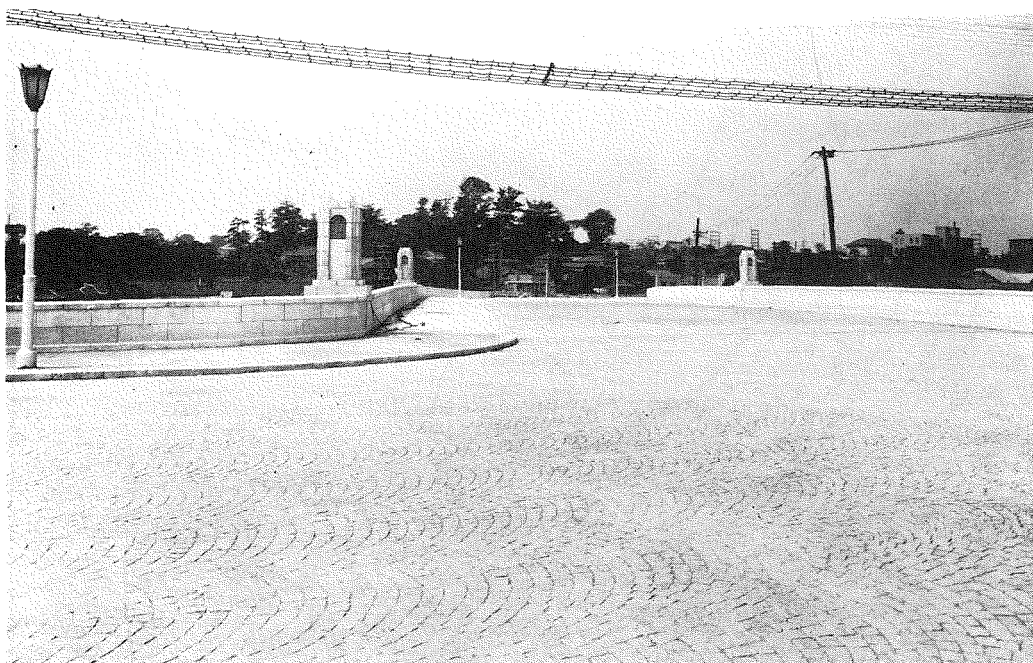
(2) 東側高架道路(屈曲部 附近)より跨線橋を望む。
