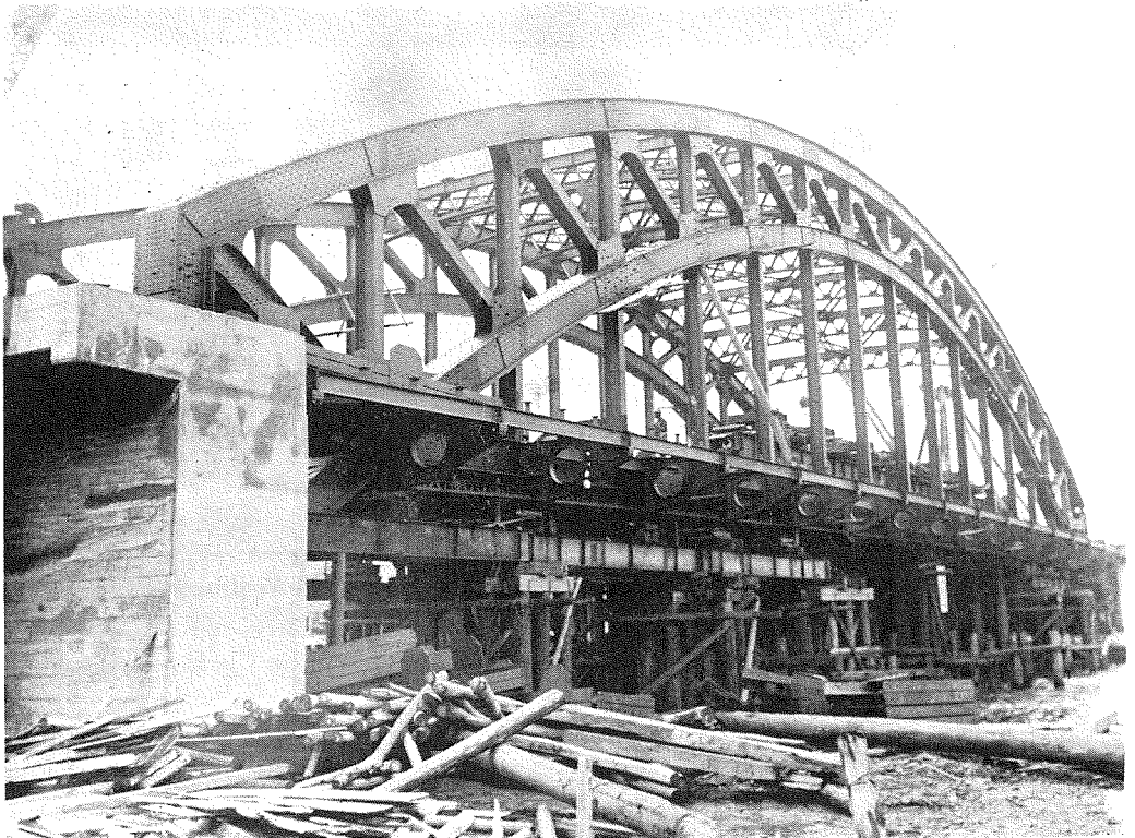
(5) 桁の架設殆んど終了し、最後に上弦を組了らんとする瞬間。
