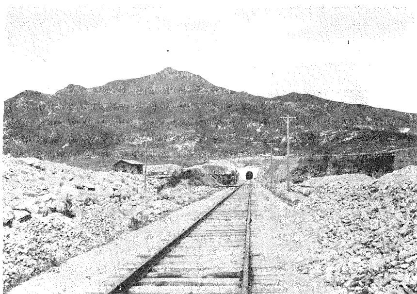
竣 成 せ る 雄 羅 線(雄羅隧道)
