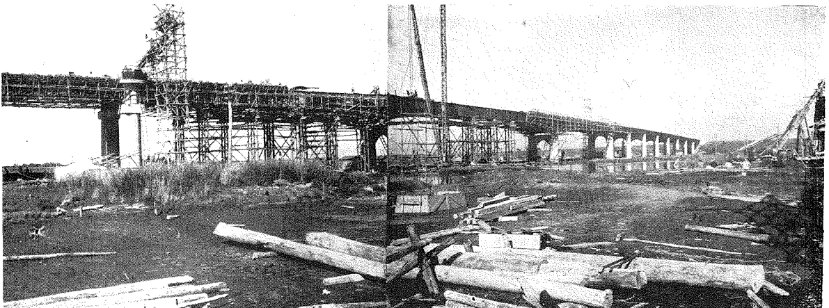
(12) 工事完了に近き江別大橋全景(前頁より続く)
