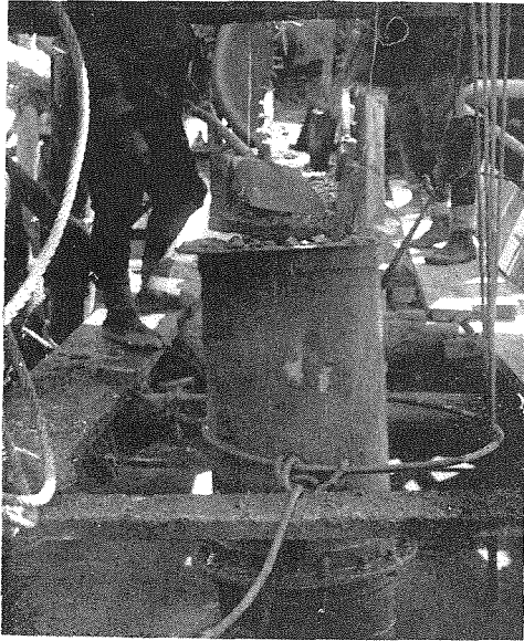
(7) 井筒水中コンクリート用の長 24米トレミー管。
