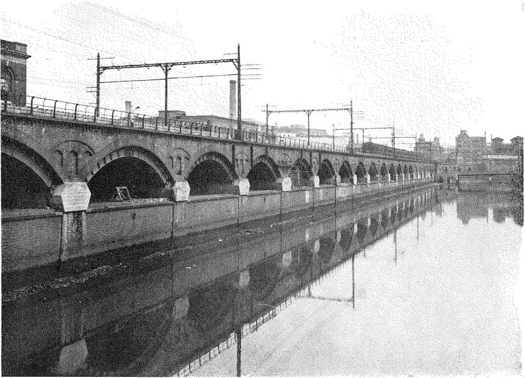
鐵道省では東京附近の大改良計畫の一たる東京濱松町間線路増設に伴ふ改良工事として外濠添の有樂町新橋間高架橋（煉瓦造拱）の補強工事を實施中のところ此程竣功した。舊拱橋の下部に三鉸鋼拱を以て補強したもので鋼拱製作及架設は櫻田機械製造所である。寫眞は補強工事の成つた高架線を示すもので、上は高架線の大觀（銀座側新橋方面より有樂町方を望む）次頁の上は<sup>1</sup>徑間の側面、下は仰觀である。
