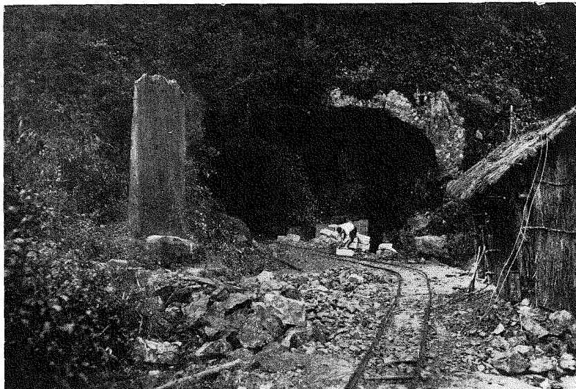
(6) 栗子隧道北口舊坑及當時の栗子隧道碑。
