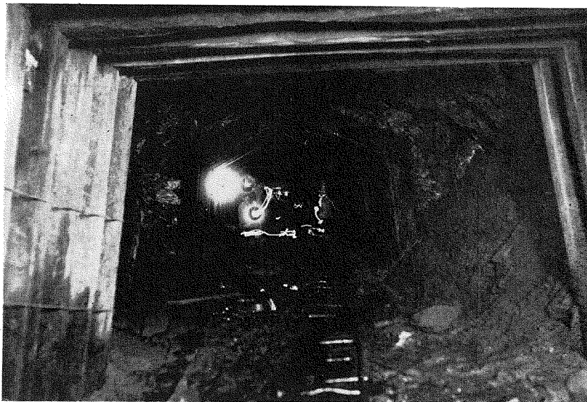
(8) 栗子隧道舊坑内部木卷部。
