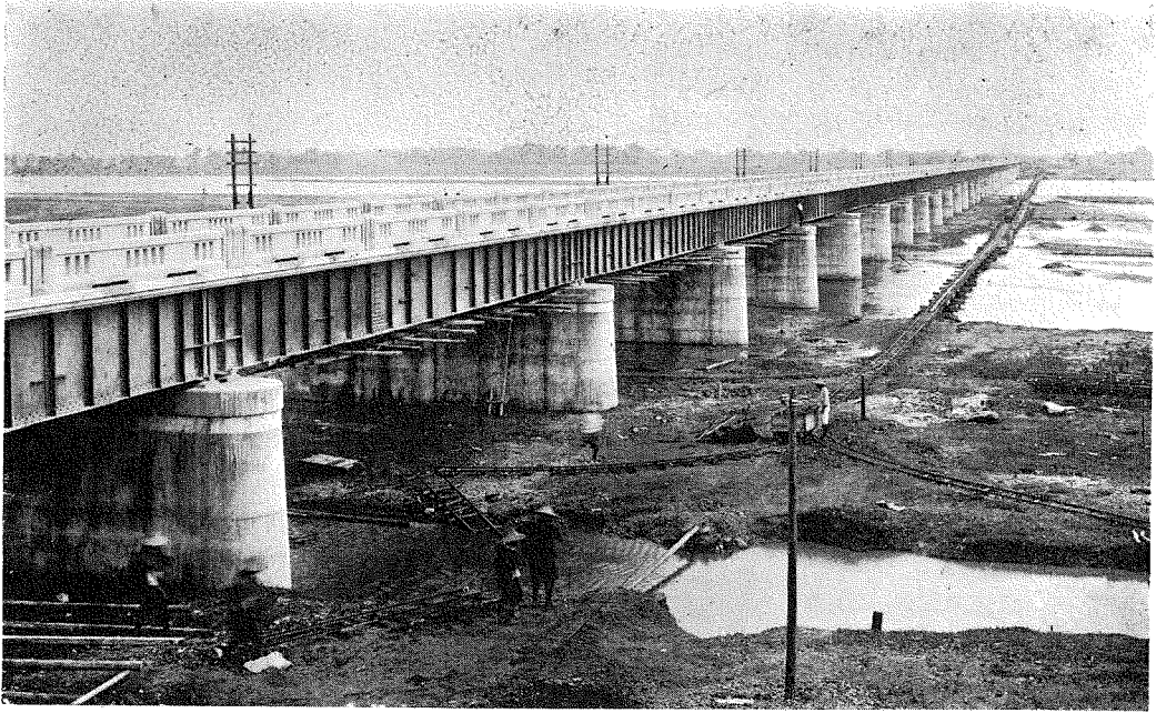
(10) 竣工近き閘陽橋を上流側より見る、 河中に横断布設せるは材料運搬経便線。
