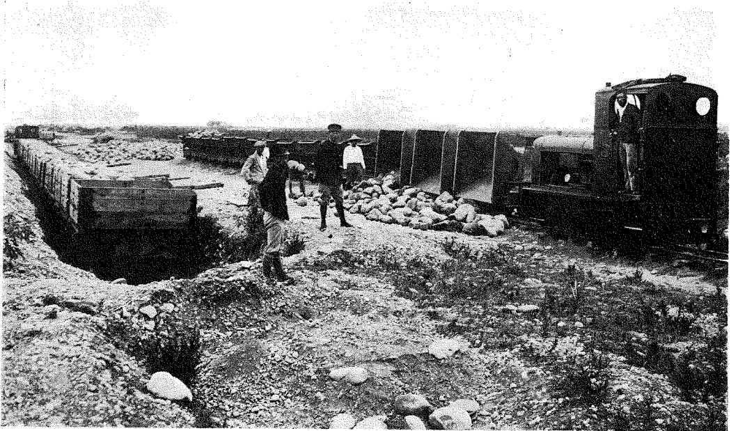
(12) 7 越ディーゼル機関車、1 粒積鐵製 土運車及 3 越積土運車による玉石運搬。
