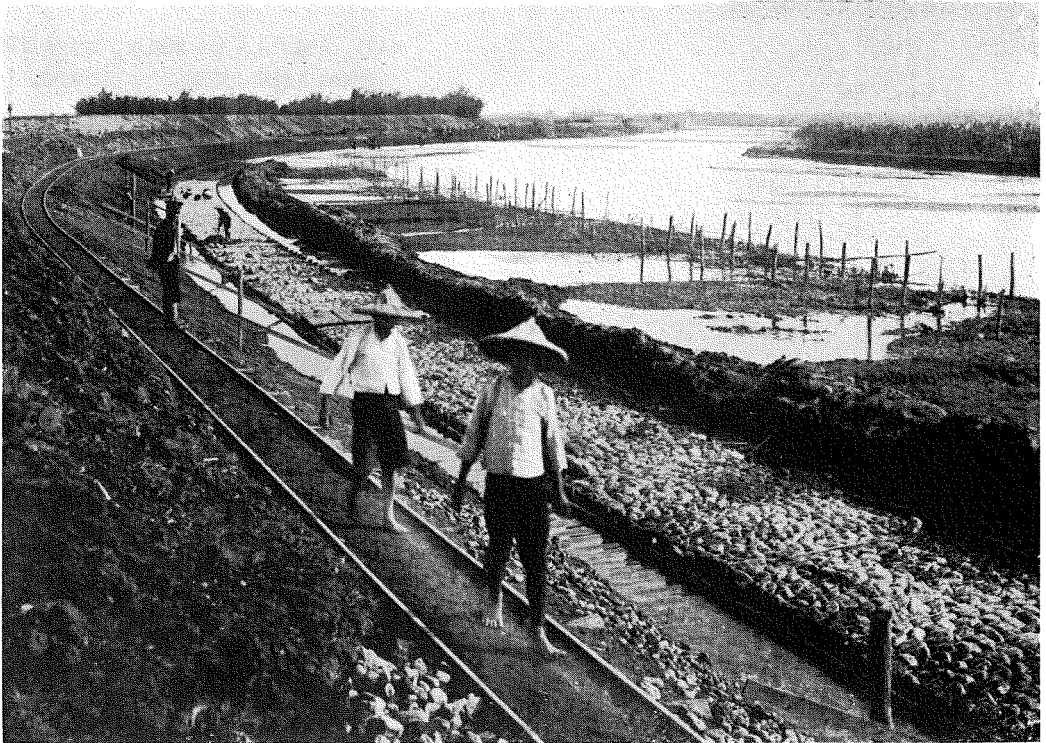
(11) 員山堤防下流部、土堤、高水敷 護岸、鐵線布團籠。
