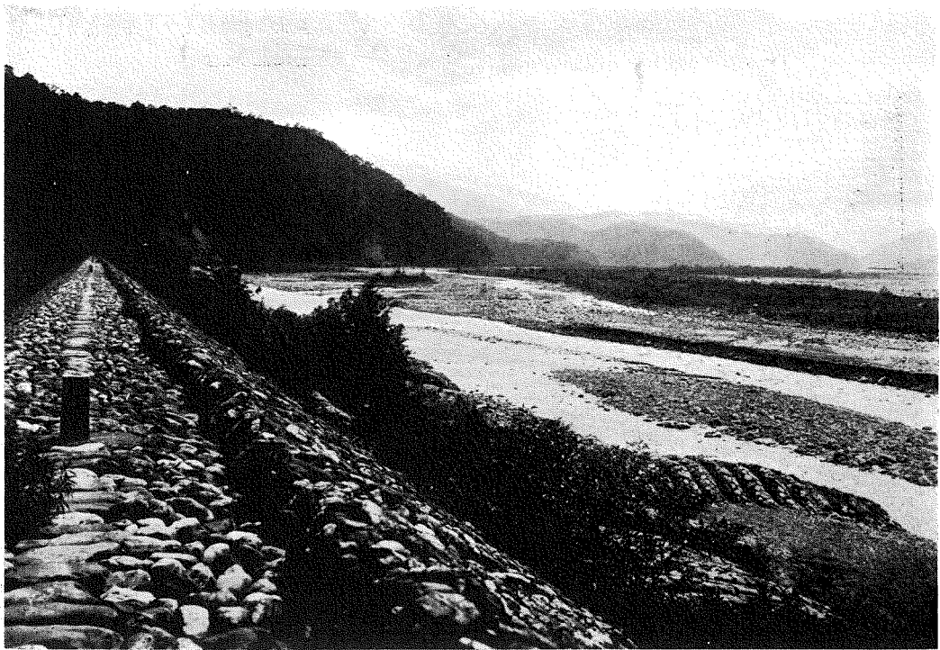
(7) 最上流破布島堤防より上流を望む、石堤及法掛鐵線蛇籠並に蛇籠水制工。
