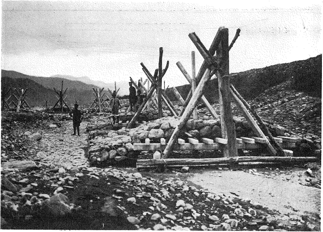
(8) 破布烏堤防の鐵筋材中聖牛。
