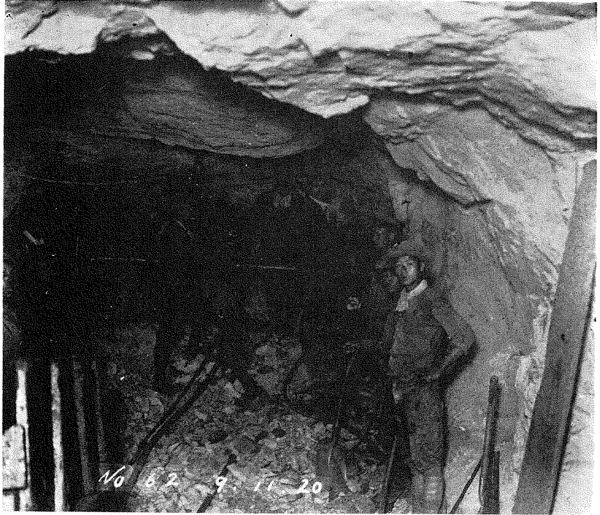
(4) 水路隧道掘削状況。
