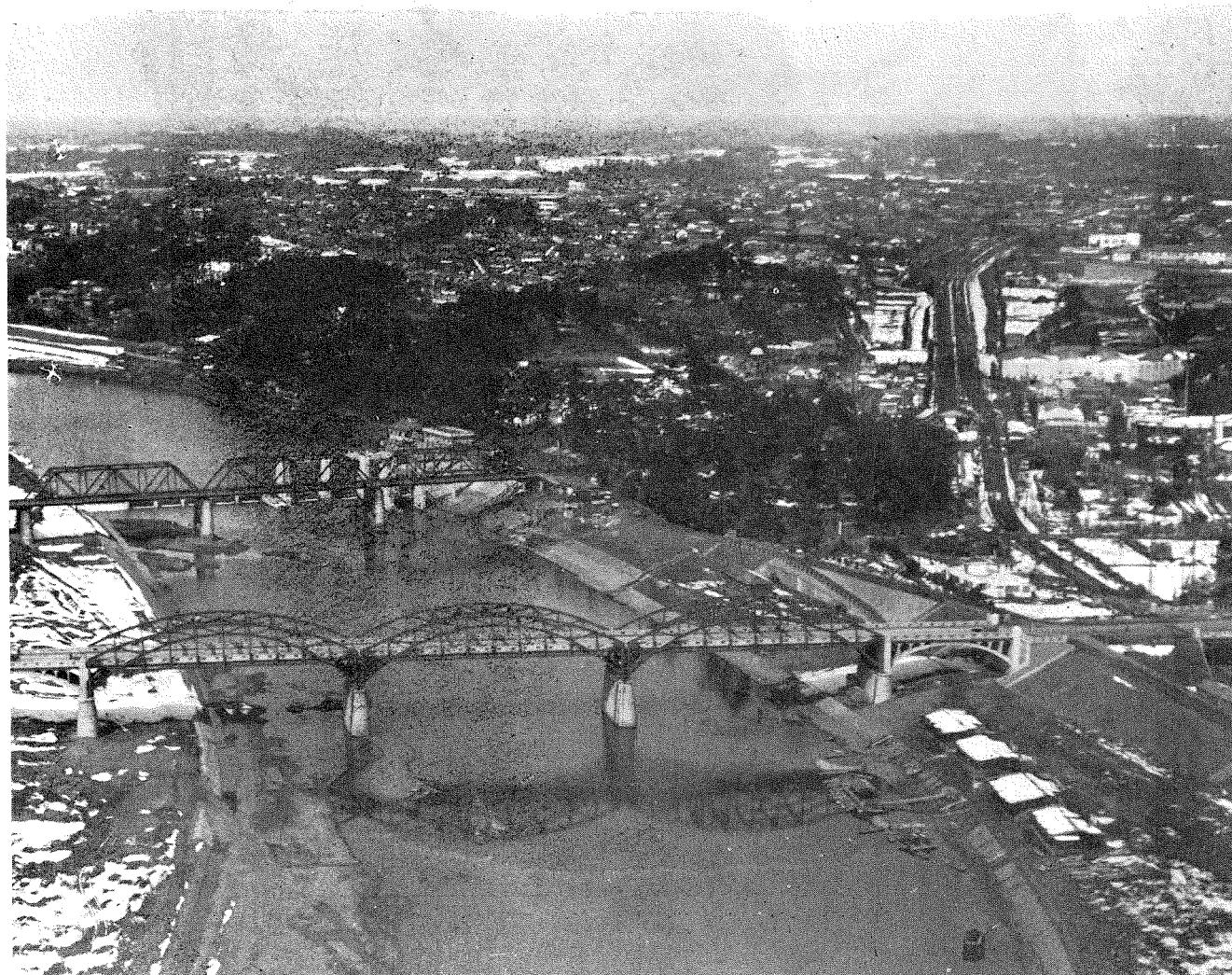
東京市水道局がかねて工事中だつた玉川水道調布取入口海水防止堰工事が竣工した。写真は空中より見たる同堰及その附近で前頁の写真は上流側より眺めたるもの左岸丘上の淨水場は玉川水道龜甲山淨水場の沈澱池と濾過池である。之は玉川水道の創設初期に造られた極小規模のもので、僅かに玉川淨水場（上掲写真の上端に僅かに現れてゐる）の補助として實用されてゐるに過ぎない。上掲写真は下流上空より堰附近を眺めたもので下流の橋梁は昨年開通した丸子橋其上流が東横電車橋、肝心の堰が此橋梁と重つてしまつたのが殘念である。（写真撮影辻村英三）
