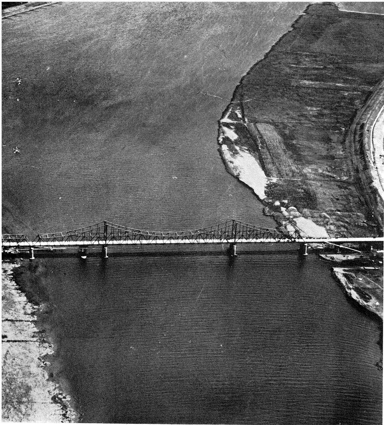
千葉県香取郡佐原町と茨城縣稻敷郡本新島村の間、利根川に架設せられた水郷大橋の航空寫眞である。橋長553米、有効幅員6米、ゲルバー鋼鈹桁12徑間、ワーレン鋼構桁1徑間（支間51米）ゲルバー鋼構桁3徑間（支間51米+91.8米+51米）である。詳細は近刊誌上に追て發表する豫定、寫眞は新日本航空寫眞測量社撮影。
