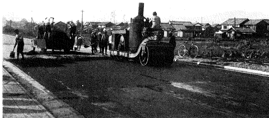
(17) 大垣市都市 計畫區域(幅員14米 60)終點附近トペカ 式舗装工事の實況。
