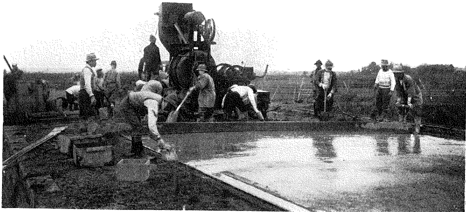
(14) 稻葉 郡鷺村地内 舗裝基礎工 事狀況。
