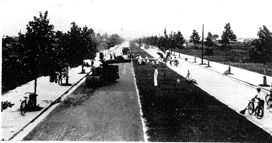
(13) 岐阜 都市計画區 域(幅員24 米60)舗裝 工事狀況。
