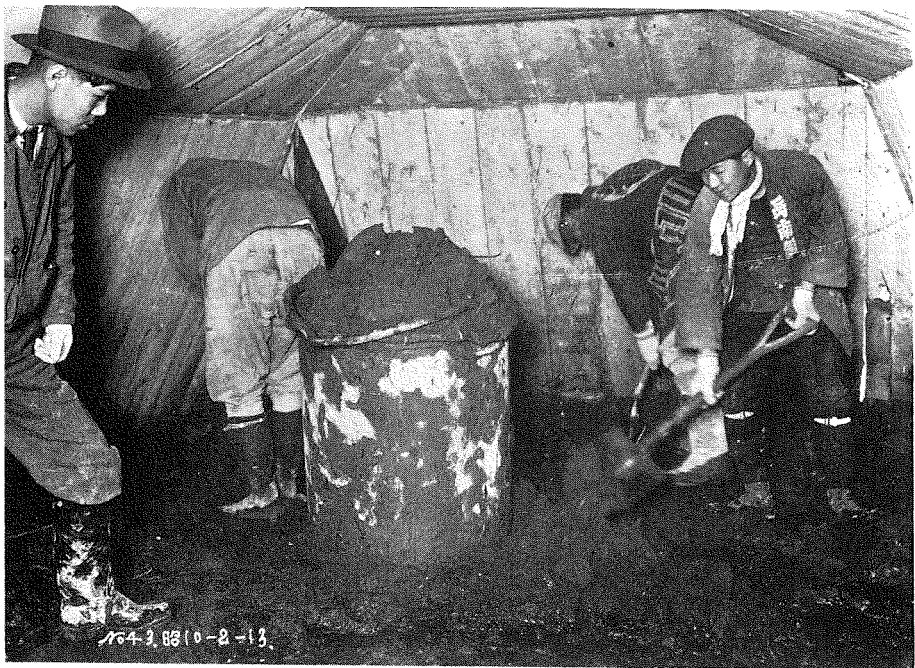
(15) 工事中の一端 (中央の2基は(型作業室コンクリート終了状態)
