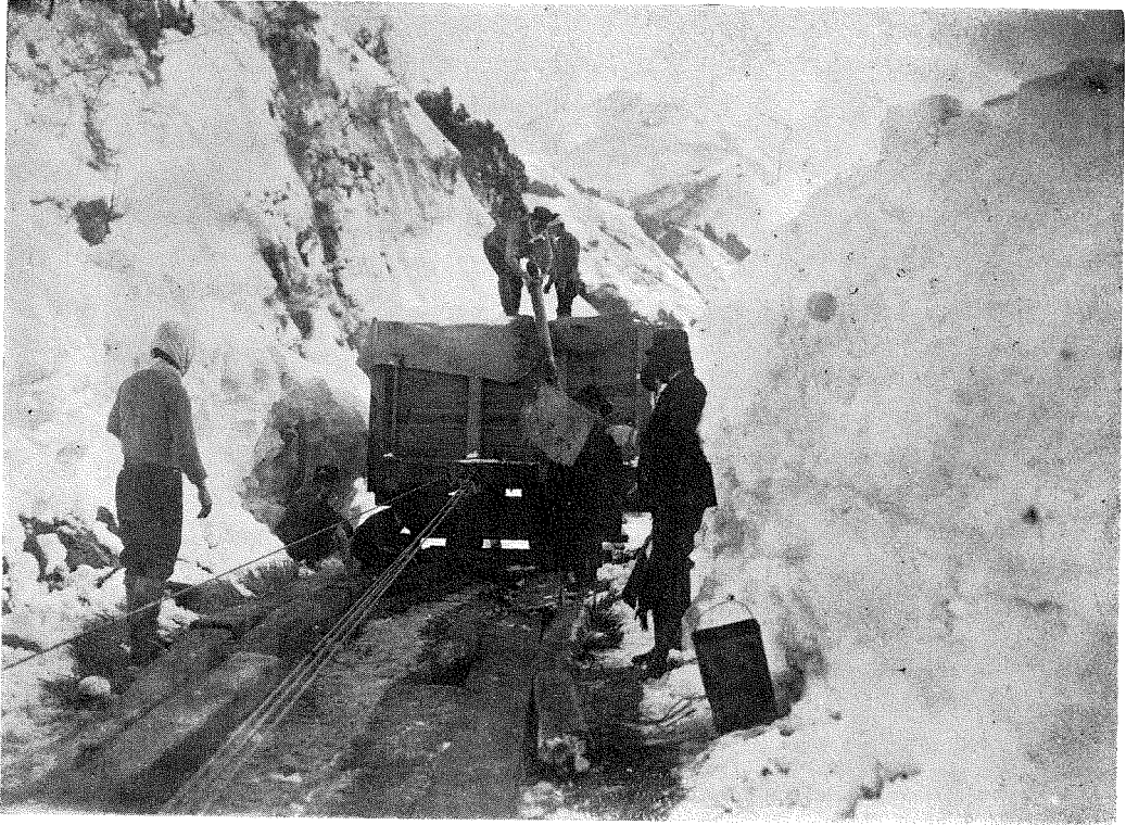
(12) 發電所附近に於ける重量物運搬實況。
