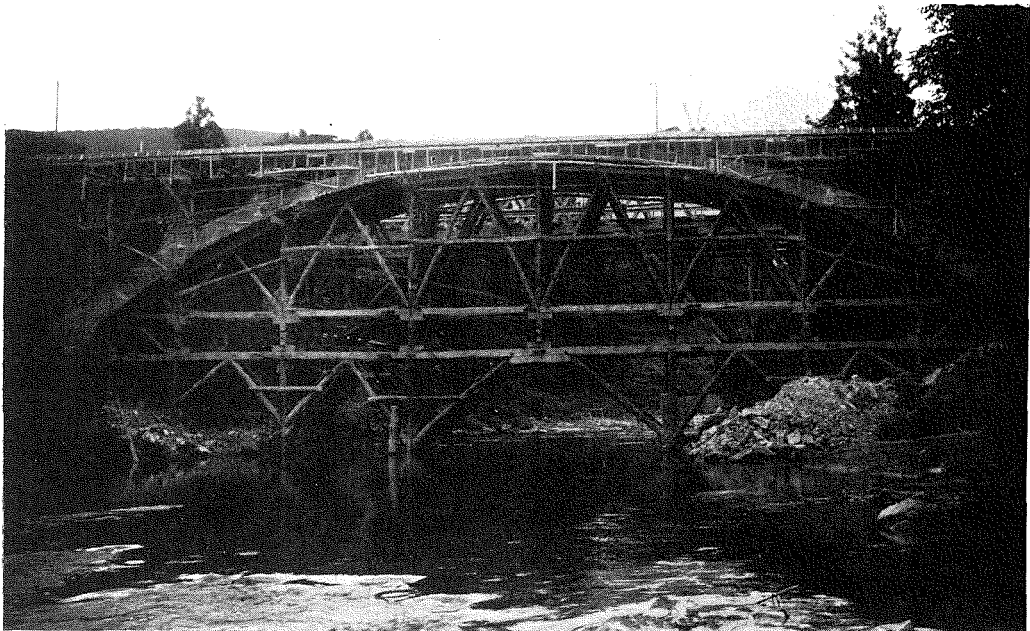
(4) 拱架並に床版コンクリート工事。
