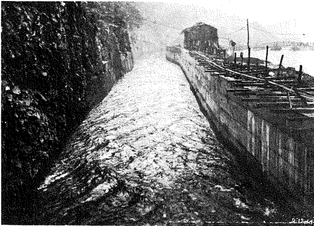
(6) 通水開始後の假排水路を堰堤中心より見る。
